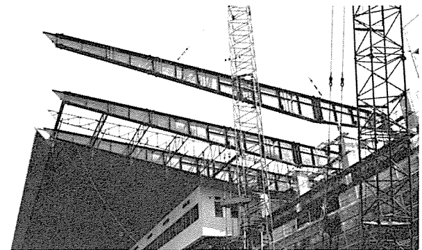
写真-7 ◇通り建方
